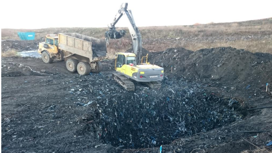
Figur 5. Pågående urgrävning, BCR01, 14 december 2016
