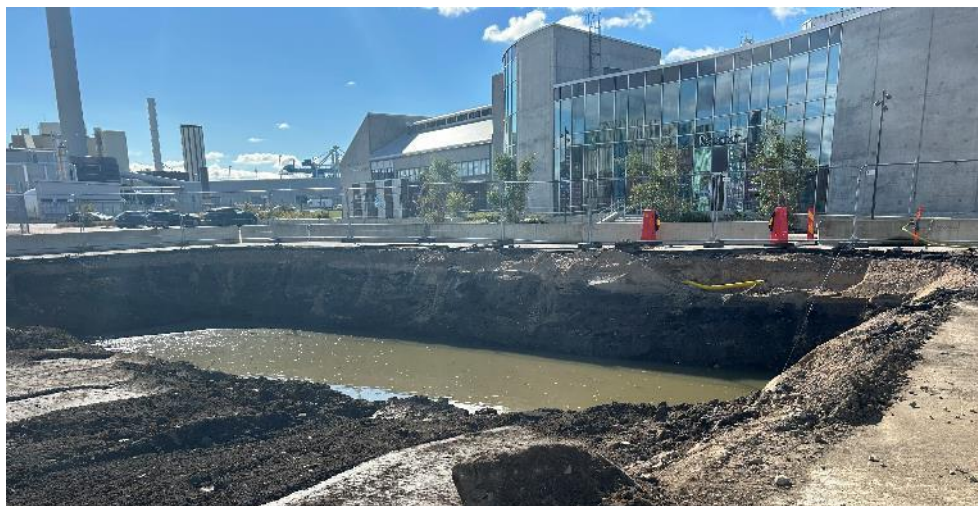
Figur 3. Oslopiren efter sanering av den ruta U7. Jorden från djupare jordlager användes i fältförsöket.
