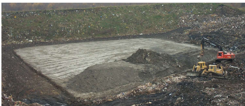
Figur 1. Lerbotten till BCR01 under uppbyggnad (2001)
