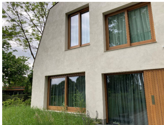
Figur 18, Närbild "Artist Residence" som byggdes med helväggsselement av hampakalk
