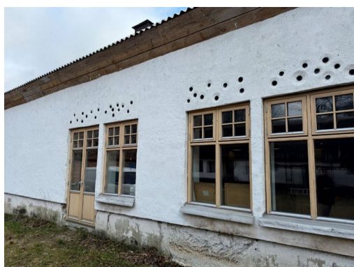
Figur 21, renovering och ombyggnation av ladugårdsbyggnad till restaurang, Mossagården.
