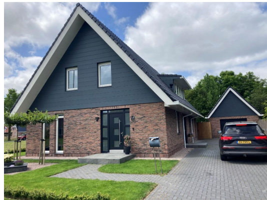
Figur 8. Hus byggt med hampakalk av DunAgro.
