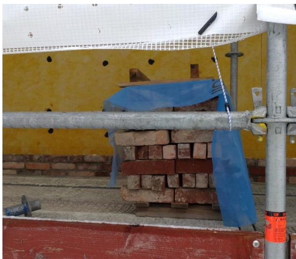
Bild 5 Pall med återbruk av tegel, fallstudie Västerås stad
