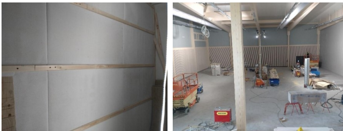
Bild 4 Undertaksplattor får ny funktion som ljudabsorbenter i idrottshall, fallstudie Västerås Stad
