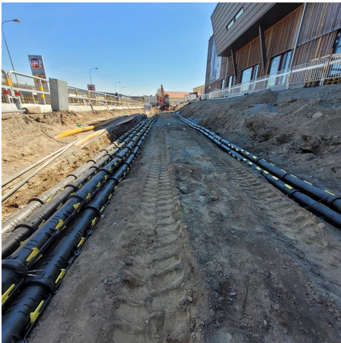
Figur 12. Tidigare oskyddade kablar eftermonteras med Greenpipes delbara kabelskydd i samband med byggnation av parkering
