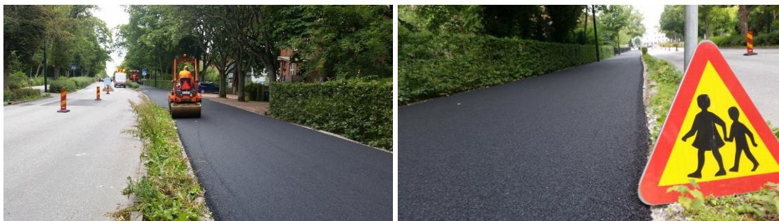
Figur 4: Läggnings av teststräcka (ca 300 m) med fallvänlig asfalt längs Dalbyvägen i Lund 13 juli, 2020.
