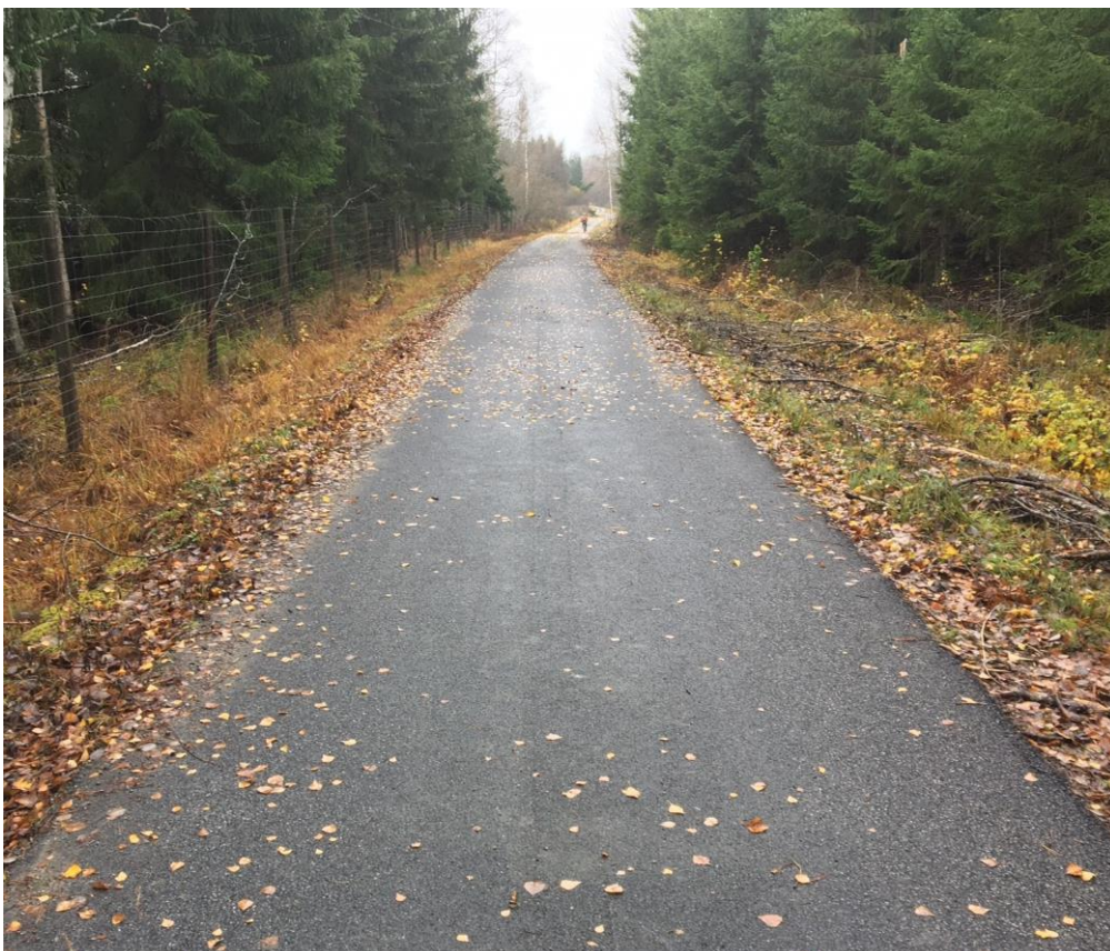
Figur 5: Teststräcka med fallvänlig asfalt i Uppsala.
