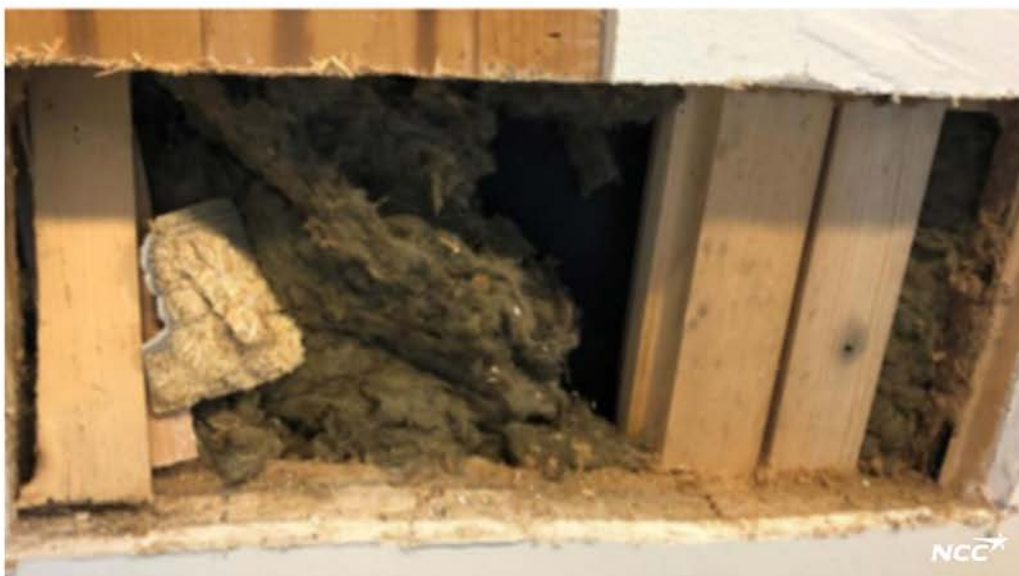
Figur 4 Håltagning i befintlig vägg vid inventering för att kunna bedöma status på befintlig byggnad och i vilken utsträckning materialet går att använda.
