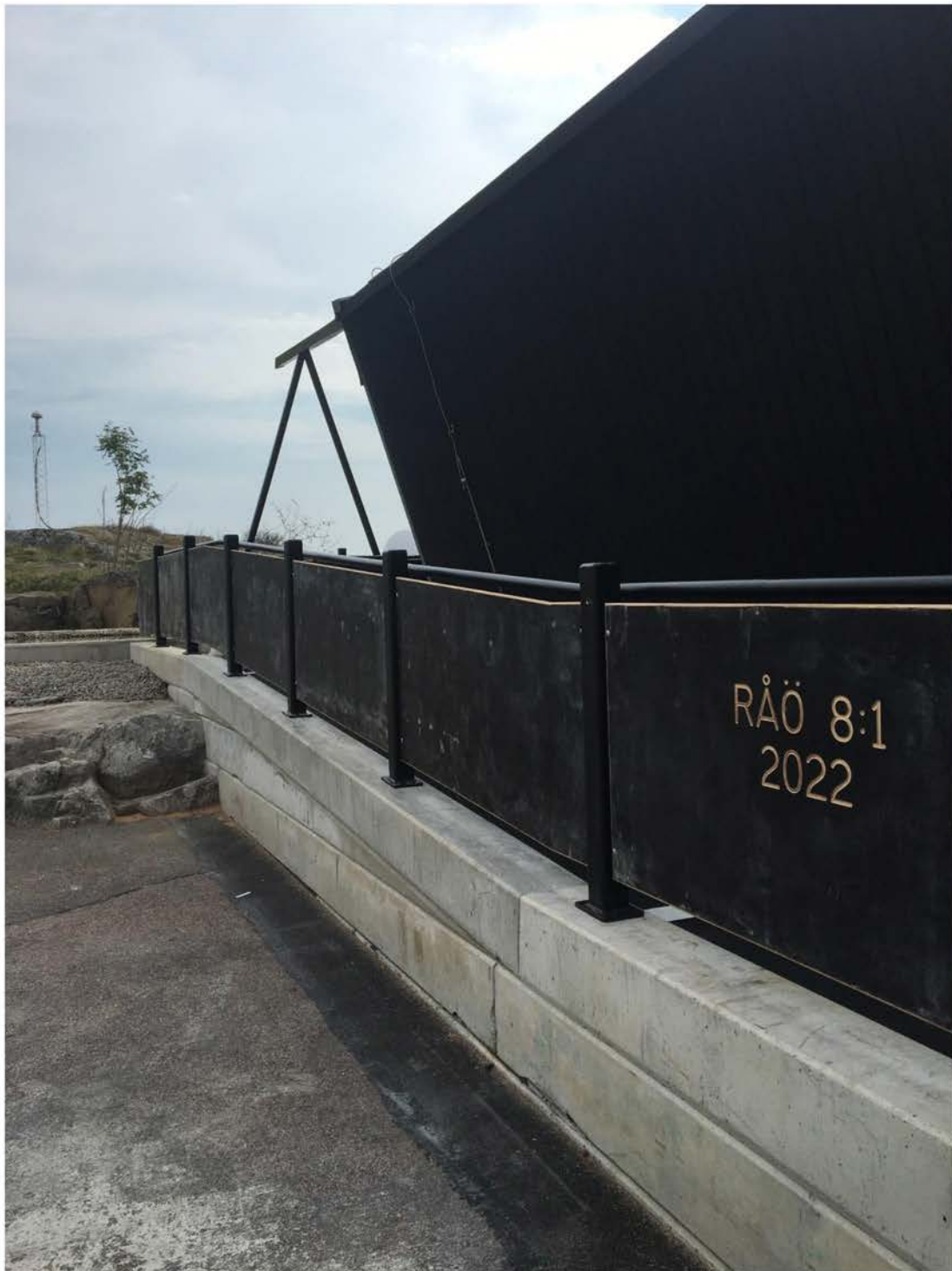
Figur 5 Tillgänglighetsramp bestående av återbrukade pålkap, formplywood samt smide.
