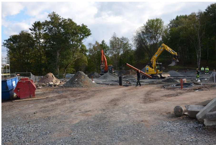
Figur 11: Byggplatsen på Backa kyrkogata i september 2020 då markarbeten pågår. I den blå containern till vänster i bild samlas rörspill in.
