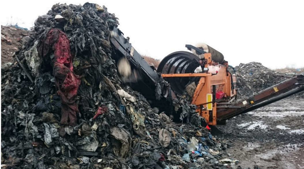
Figur 6. Siktning av uppgrävt avfall i två fraktioner (såll 40 mm).
