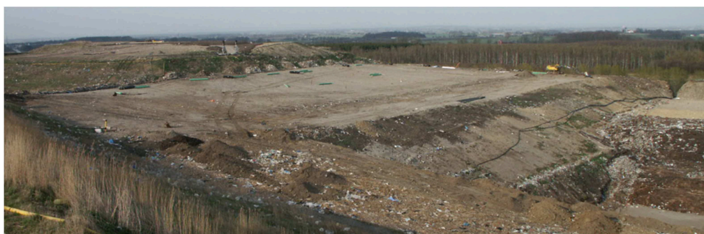
Figur 2. BCR01 efter inläggning av avfall och inkapsling med tätduk (oktober 2002)
