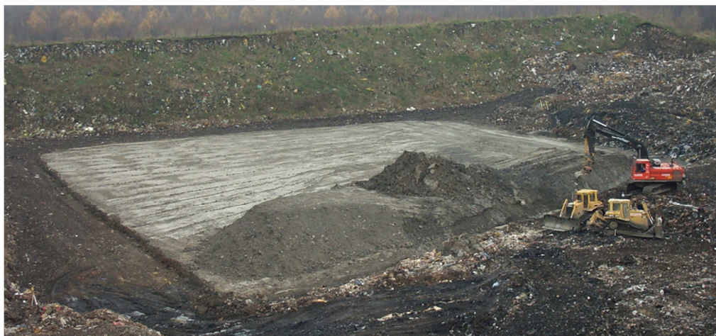
Figur 1. Lerbotten till BCR01 under uppbyggnad (2001)
