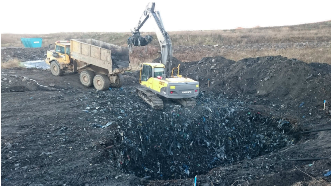
Figur 5. Pågående urgrävning, BCR01, 14 december 2016
